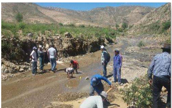
Construcción de un tajamar y muro de contención para captación de agua y protección de áreas de cultivo municipio de Vitichi
