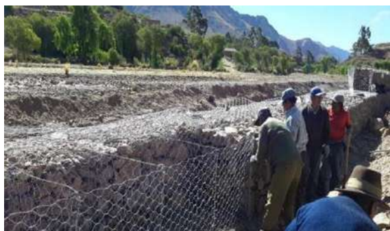
Construcción de gaviones para la protección de áreas cultivos en el municipio de Las Carreras
