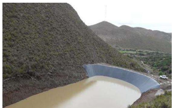
Presa de Tierra revestido con geomembrana con una capacidad de almacenamiento de 230.000 m 3 en la comunidad de muyuquiri del municipio de Camargo.
