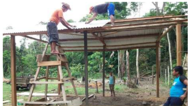
EEP Construcción de Gallinero en la Comunidad Blanca Flor, Municipio San Lorenzo
